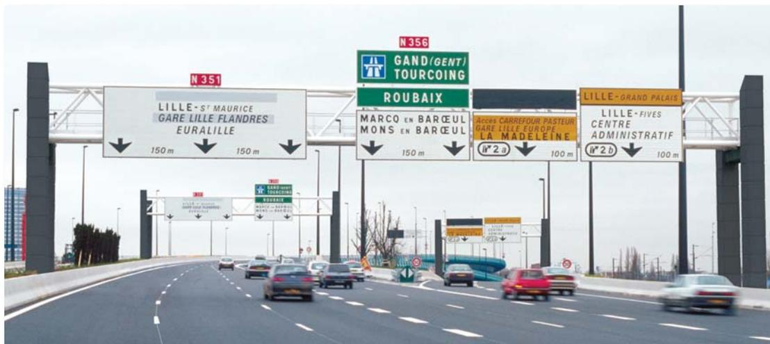
1996 - Lille : réalisation de passerelles tubulaires posées sur montants en béton pour supporter la signalisation verticale
