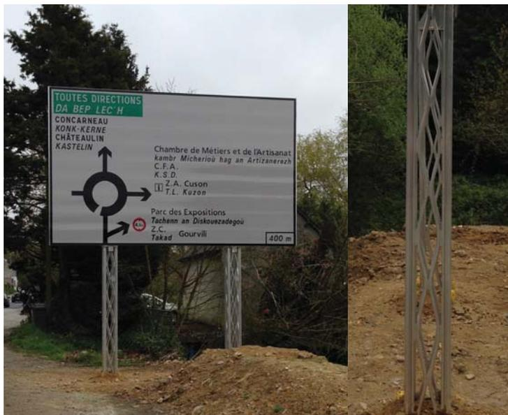
La hauteur du mât à sécurité passive doit être au minimum égale à la hauteur sous panneau qui ne peut être inférieure à 2 mètres.
