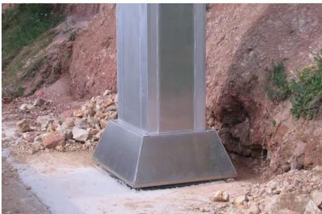
Dans le cas d'une structure positionnée à proximité d'une zone piétonnière, il est possible de masquer les ancrages du montant par un capot qui reste démontable afin de pouvoir effectuer les visites périodiques.
