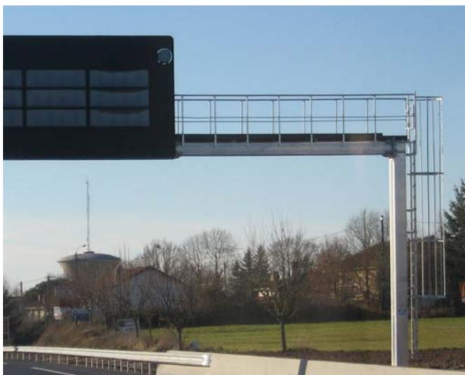
Afin d'accéder à la passerelle, les montants peuvent être équipés d'une échelle avec crinoline. L'accès se fait couramment par le montant droit en B.A.U.
