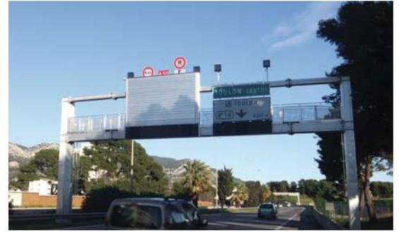
2013-Tunnel de TOULON: réalisation de 3 portiques double poutre avec équipements d'accès pour supporter de la signalisation statique et dynamique par prismes.
