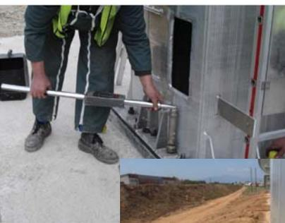
Les assemblages sont serrés à la clé dynamométrique suivant les recommandations du dossier de pose fourni avec la structure
