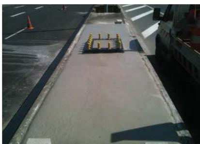
Le massif est coulé en aérien entre les GBA existantes sans démolition de celles-ci. Dans le cas d'une structure nécessitant une alimentation électrique, des fourreaux sont mis en place sur le fond de fouille et recouverts ensuite par le béton.
