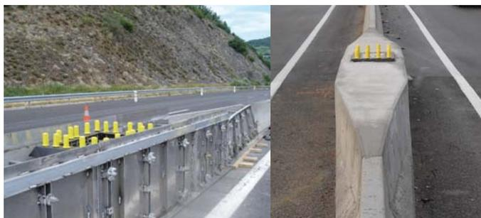
Le massif est coulé en aérien et intègre 2 dispositifs d'élargissement de DBA de 4m50. Cette solution permet de réhausser l'embase de la structure et de faciliter le contrôle périodique des ancrages (il n'est pas nécessaire de venir démonter des capots GBA pour inspecter les scellements).
