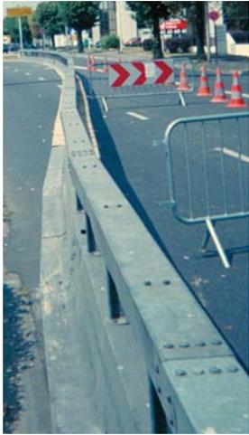
Séparateurs de voies BT3, BT4 (norme ASI) pour chantier longue durée, avec système de rippage. Ripage continu de 5 km/h, avec amplitude maximale de 12 m = 4 voies. Depuis le 01 Janvier 1998, les séparateurs modulaires de voies de classe B utilisés en protection de chantier, doivent être agréés (circulaire n°97-66 du 08/08/97 - AFNOR XP P 98 453).
