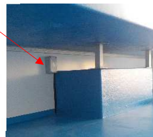
Alimentation 12 v sous le bac derrière auvent pour branchement balance
