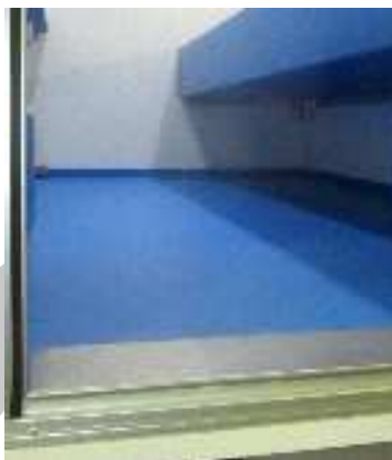
Revêtement résine polyester LISSE Avec finition marée et platelage inox à l'entrée de la porte arrière
