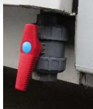
4 bondes d'écoulement : 2 siphons à l'arrière 2 vannes 1/2 à l'avant
