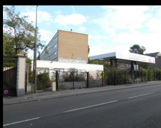
Ancienne station essence déconstruction avec présence d'H.A.P., réponse complète au dossier d'appel d'offres - Lille
