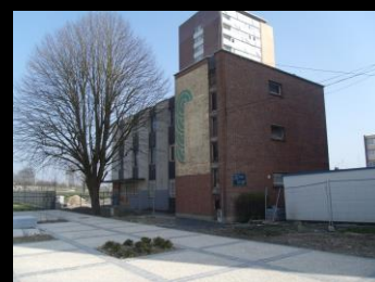
Déconstruction d'une salle des fêtes, étude technique et financière, travaux d'aménagement de la place limitrophe en cours - Lambersart
