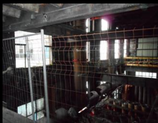
Etude technique et financière pour le démantèlement d'une chaufferie industrielle avec problématique amiante - Nantes
