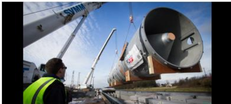
Lever le laveur, le maintenir bien droit en l'air, pour que le marinier avance sa péniche à la position voulue... Du grand art ! PHOTOS SÉVERINE COURBE
